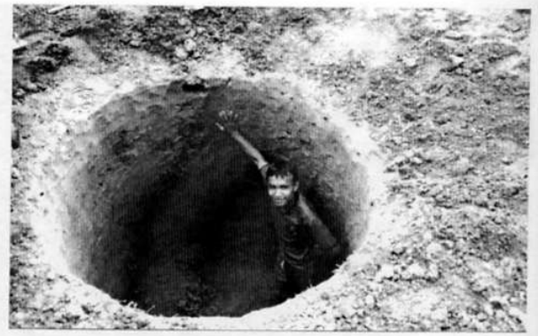
Le puits, creusé à la main par les habitants, fera un mètre de diamètre une fois muni des buses en béton pour une profondeur de 8 à 10 mètres.
